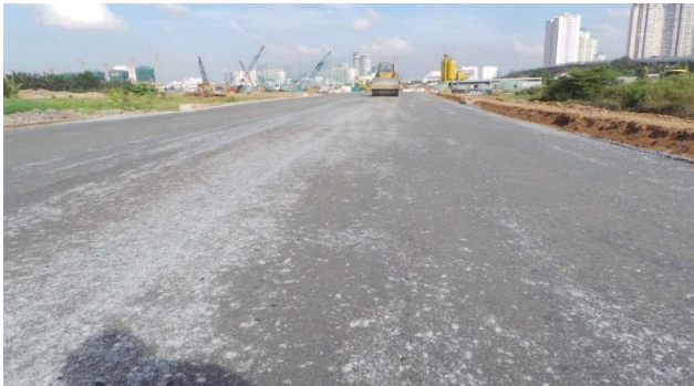
Thi công cấp phối đá dăm đường R10
