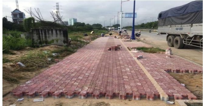
Lót gạch vỉa hè đoạn gần Ngã tư Bình Thái
