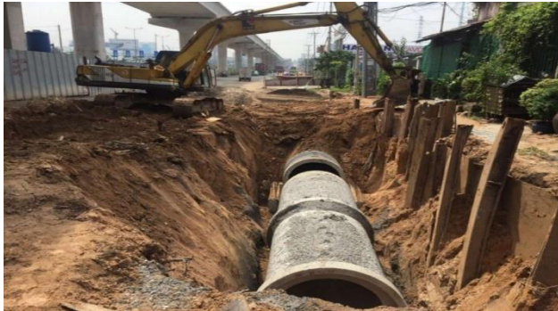
Thi công cống đoạn qua ga Metro Khu công nghệ cao
